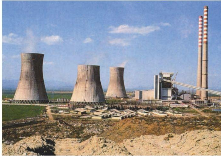
REK "Bitola". Paraqet strumbullar i elektroekonomisë së Maqedonisë. Në vit siguron nga 3400 KWO energjisë elektrike.
